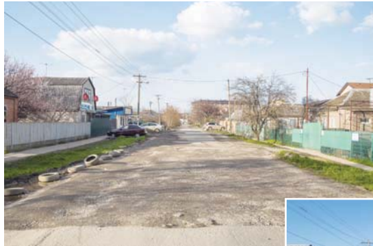
Улица Труда до ремонта
