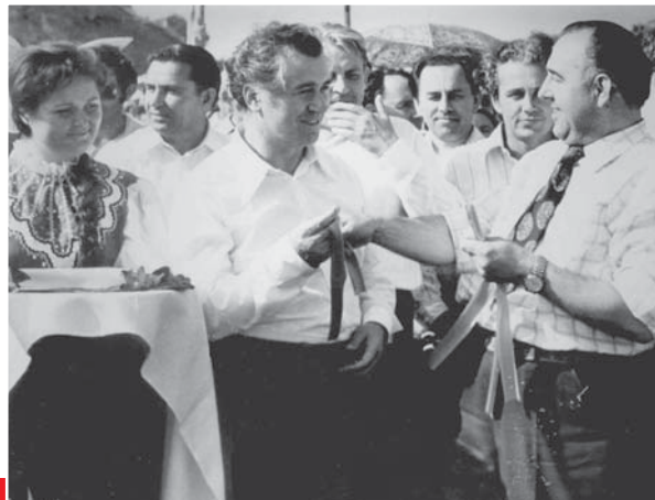
Ввод моста через Кубань в Усть-Лабинске (1978)
