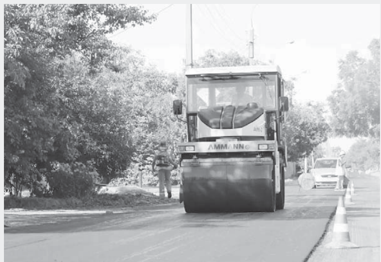
Реализация на территории краевого центра национального проекта «Безопасные качественные дороги»
