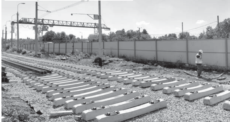
Укладка рельсов на западной линии
