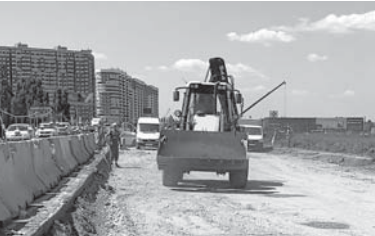
Началась реконструкция Западного обхода краевого центра
