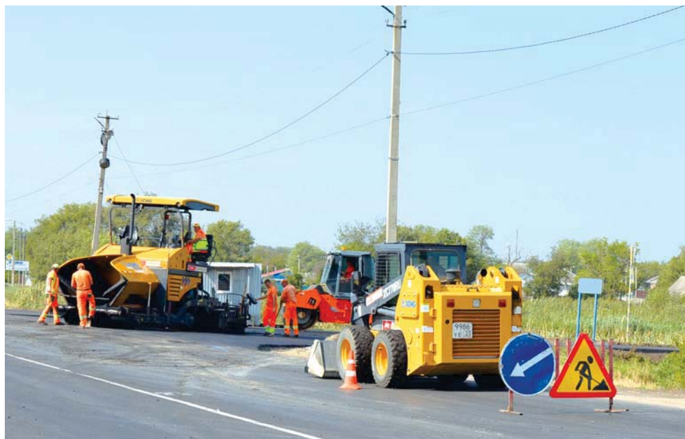
Ремонт дорог — жаркая работа
