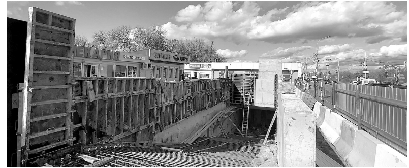
Продолжаются работы по возведению подземного пешеходного перехода на улице Дзержинского в районе ее пересечения с улицей Нахимова.
