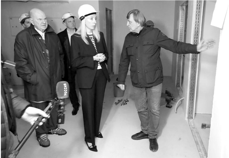
Исполняющая обязанности заместителя Губернатора Краснодарского края Анна Минькова проверила ход строительных работ реабилитационного центра.
