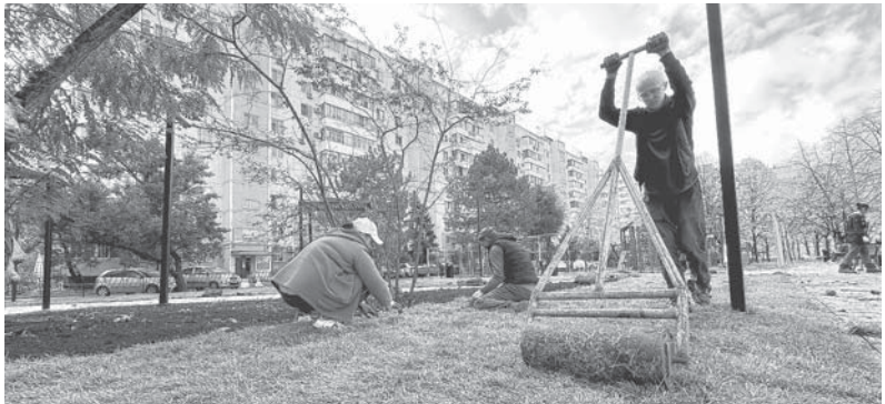
Ведутся работы по озеленению двух городских территорий: в сквере имени Захария Чепеги и на Шаляпинском бульваре
